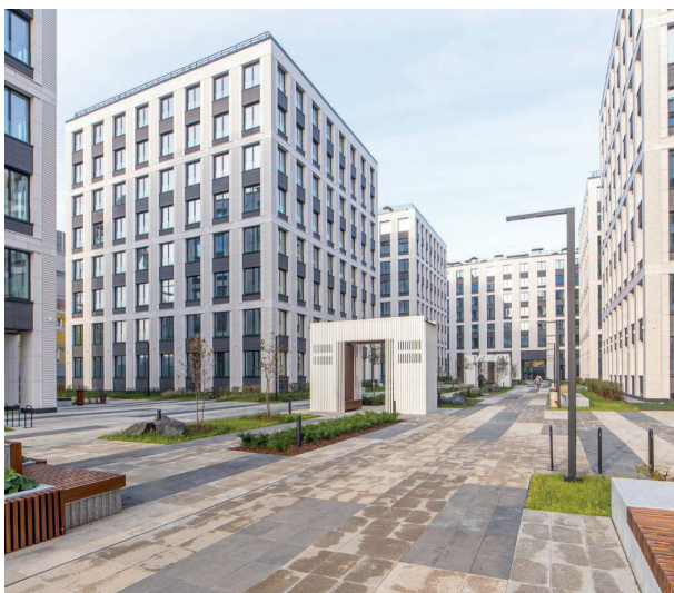
ЖК Grand View Setl Group, г. Санкт-Петербург
